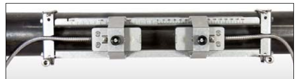
Измерение датчиками, смонтированными на портативном Variofix VP
